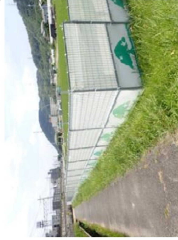
【参考写真】仮囲い取付後イメージ写真（H1800工事用フェンス）
