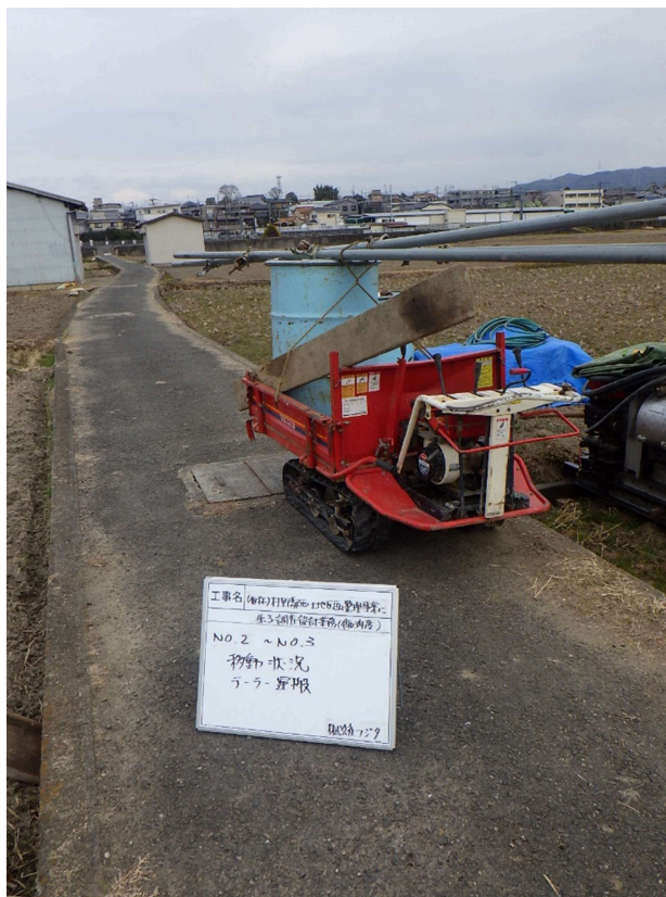
写真2.1 特装車(クローラー)運搬による資機材搬入出状況
